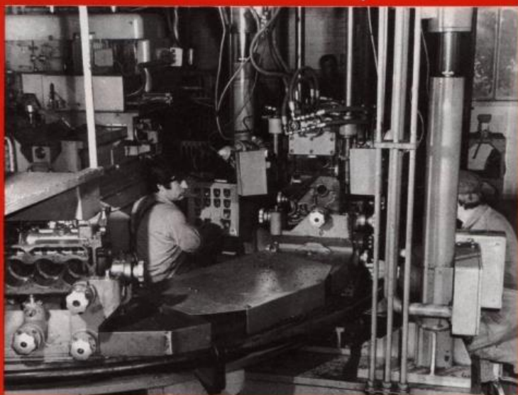
▼ Le carter-moteur est ensuite peint, pour éviter l'oxydation. Il reste à s'assurer que la pièce est usinable. Pour ce faire, elle est présentée sur un montage qui permet de vérifier et de répartir les surépaisseurs d'usinage. Enfin quatre touches sont fraisées sur la pièce : elles serviront de point de départ pour le travail d'usinage.
