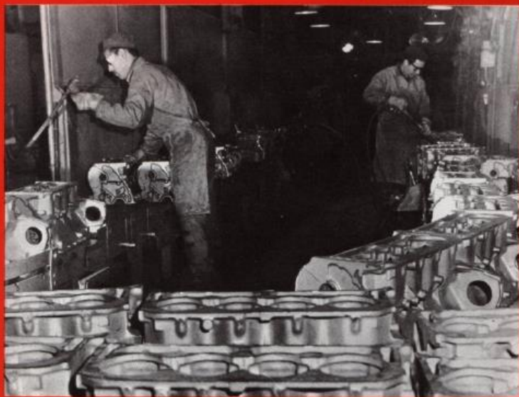
▼ Après un temps de refroidissement, le moule est décoché, le sable en partie récupéré; le carter-moteur apparaît à l'état brut. Il va subir une première opération de décapage par projection de grenailles. Il sera ensuite « ébarbé », opération qui consiste à enlever, à la meule ou au burin, toutes les parties superflues.
